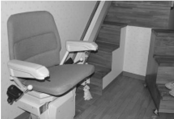
住宅改修には発想の転換が必要。階段を切り取ってリフトに乗り移るスペースを創出した例。
